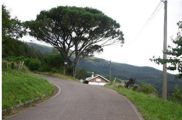
Vista P.K 2.300 T.C Coba en sentido correcto del tramo
